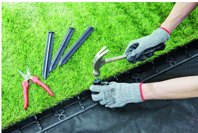
Neviditelný obrubník s kotvícími prvky
